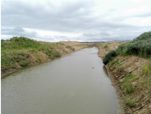
新开挖河段向上游看
