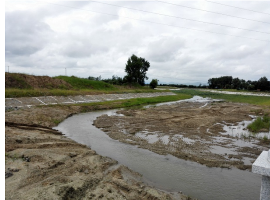
新开挖河段向上游看
